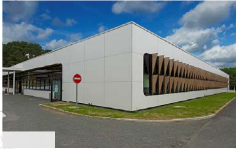
Restructuration Bât. C (TC)
