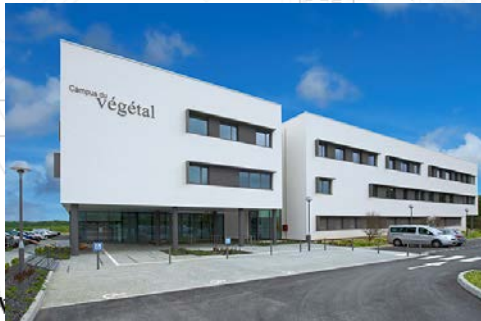
Restructuration Bât. A&B (TF)
