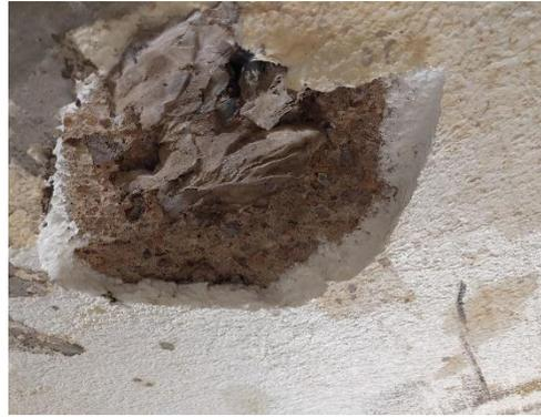
Plancher bas béton isolé 2cm polystyrène – Bat A
