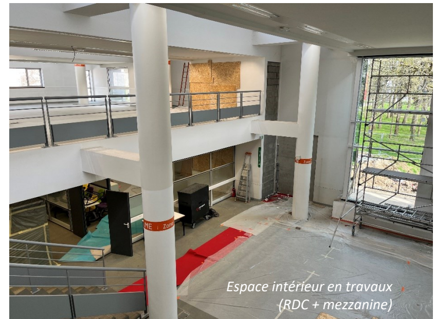
Perspective fin des travaux d'isolation extérieure (Septembre 2023) – Façades Nord et Est
