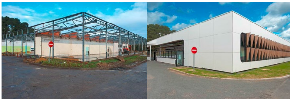
Le bâtiment C de l'IUT, datant de 1968, a été mis à nu, puis reconstruit de mars 2014 à janvier 2015 selon les normes du label Très haute performance énergétique.
