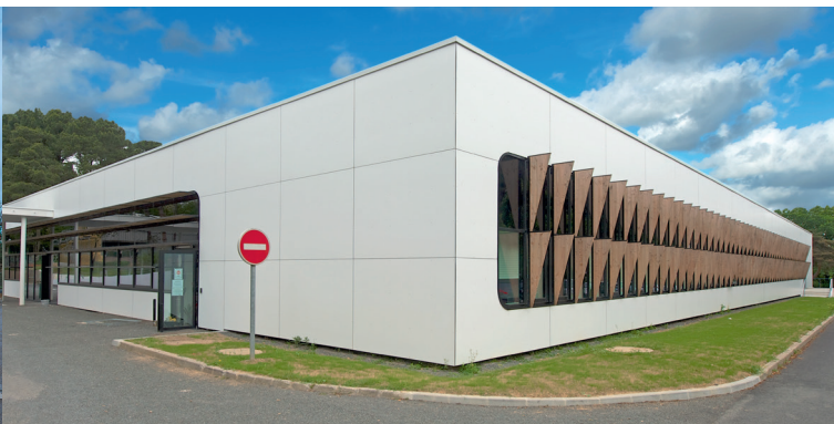
Le bâtiment C de l'IUT, datant de 1968, a été mis à nu, puis reconstruit de mars 2014 à janvier 2015 selon le label Très haute performance énergétique (THPE).
