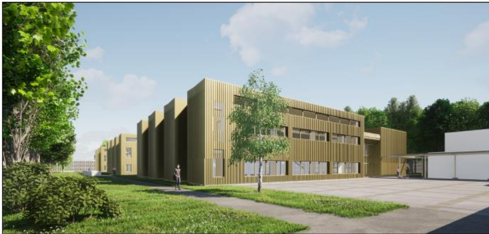
Isolation par l'extérieur et changement huisseries et porte principale remplacée par une porte coulissante plus accessible PMR et malvoyants.
